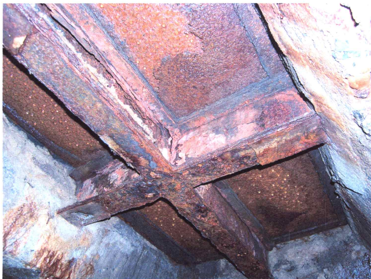
Nosné ocelové válcované profily - otvory nad násypkami:
