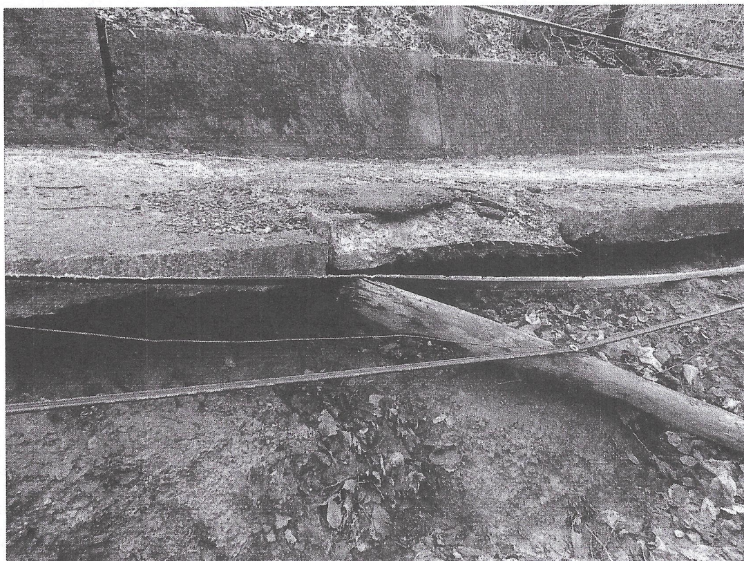
Celkový pohled na kaverny
