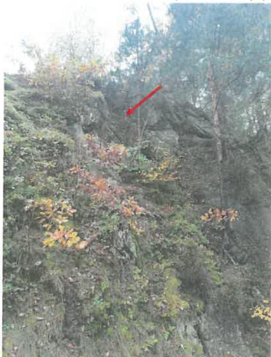
Obr.1 – pohled na skalní svah za domem č.p.186/14
