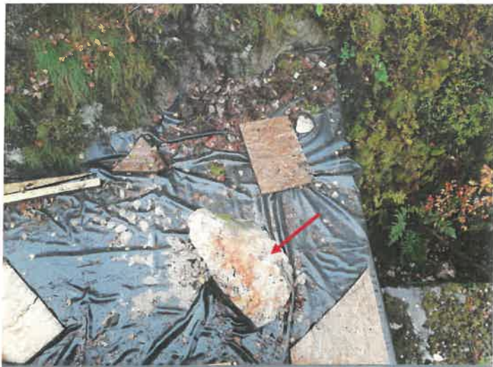
Obr.2 – Padlý blok 0,05 m 3
