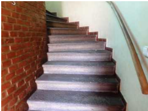
schodiště do podkroví
