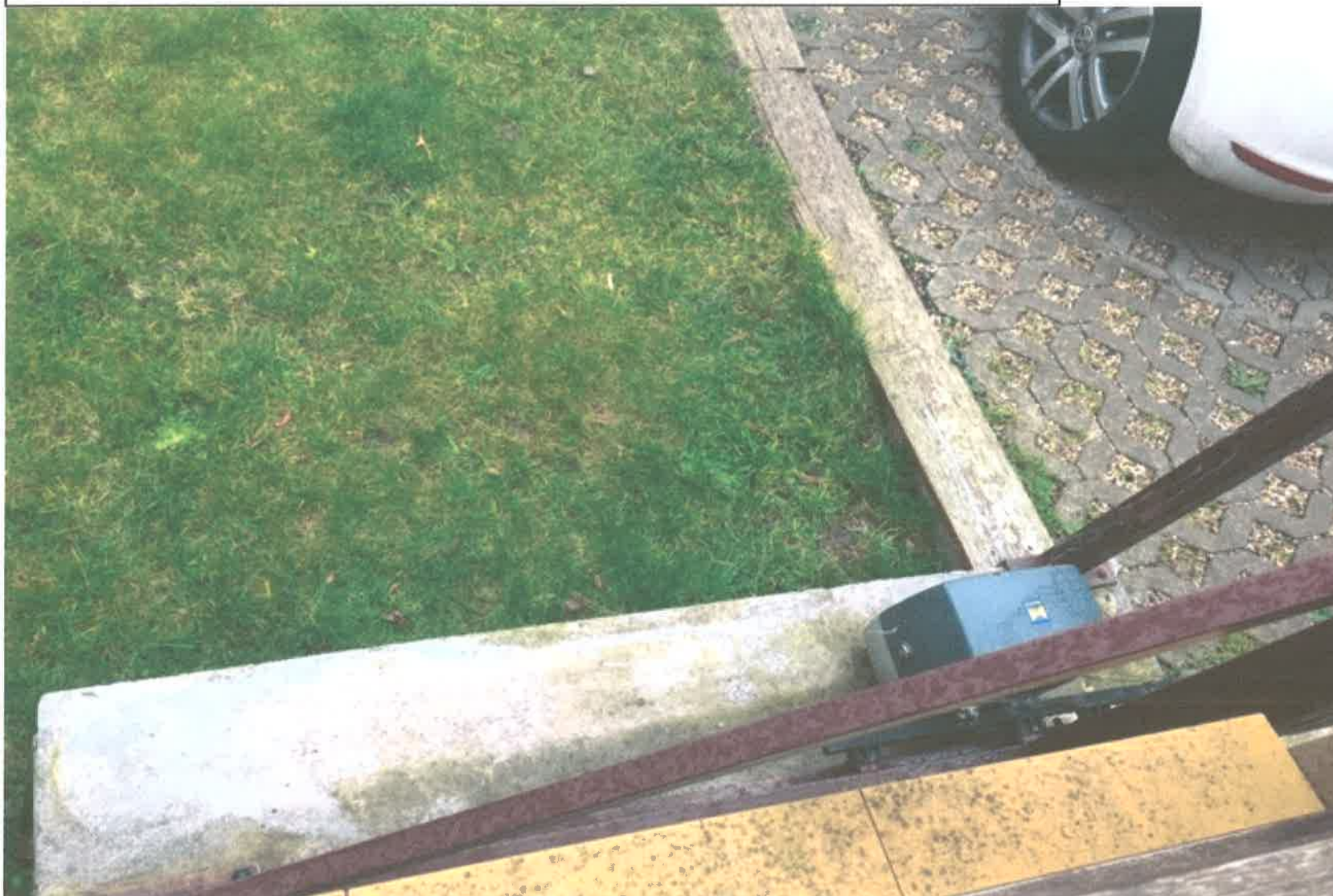
Detail betonového základu s umístěním pojezdového mechanismu
