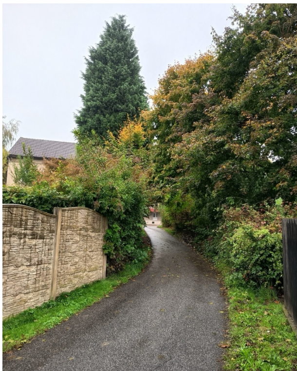
Obrázek 11_Foto z místního šetření dne 8.10.2025 – Hlavní příjezdová místní komunikace, ul. U Ovčince
