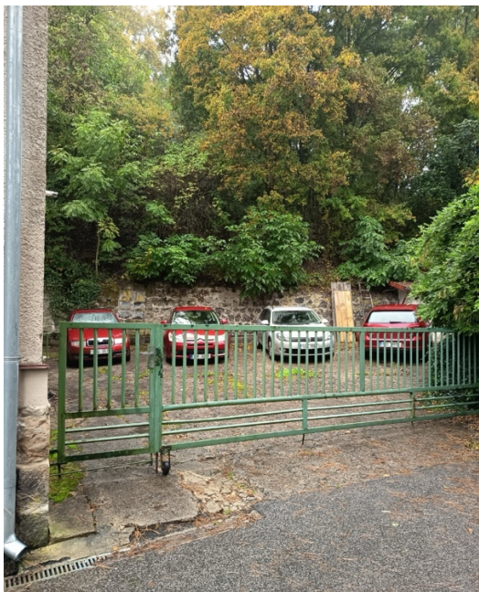
Obrázek 15_Sousední nemovitost žadatele. Svah na úpatí zajištěn stávající kamennou opěrnou zdí.
