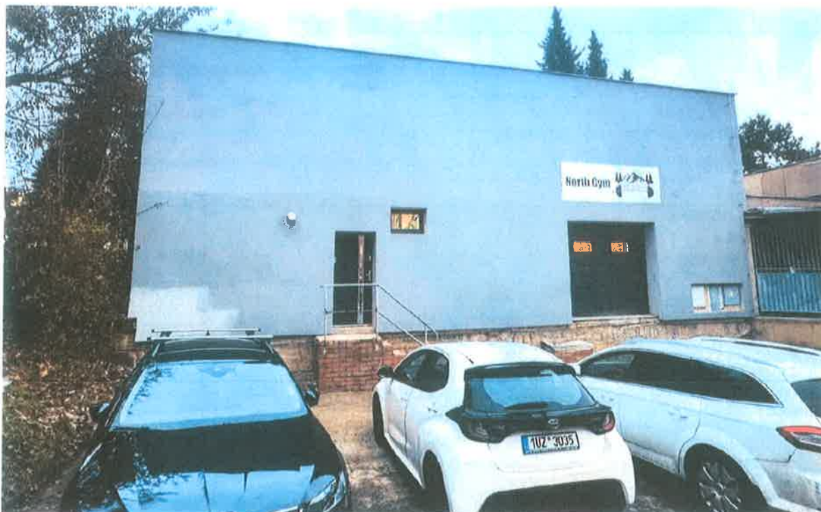
Obrázek 3 – Stávající stav, fotodokumentace žadatele. Dle KN se jedná stále o stavbu technického vybavení.
