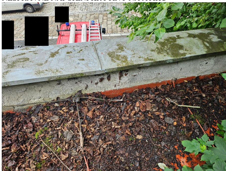
NESPRÁVNÉ NAPOJENÍ KRYTINY NA ATIKU
