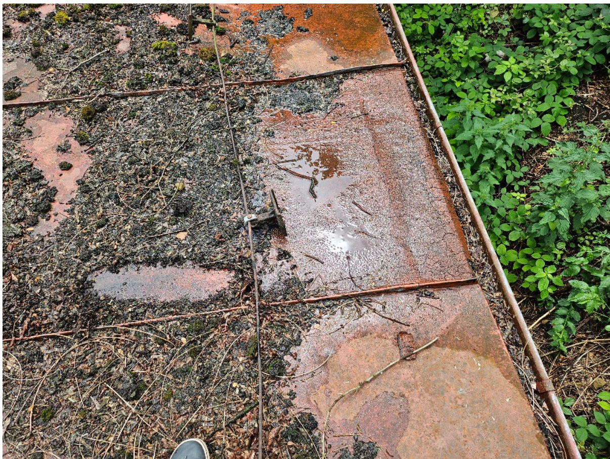
OPRAVA PORUCHY PLECHOVÉ KRYTINY Z ŽIVIČNÝCH PÁSŮ
