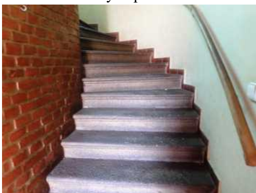
schodiště do podkroví
