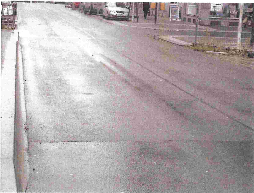
Obrázek 13 – ul. Prokopa Holého – podélné koleje u autobusové zastávky
