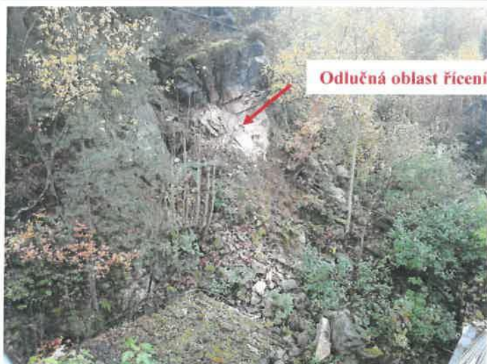
Obr. 4 – pohled na svah p.p.č. 1476/41
