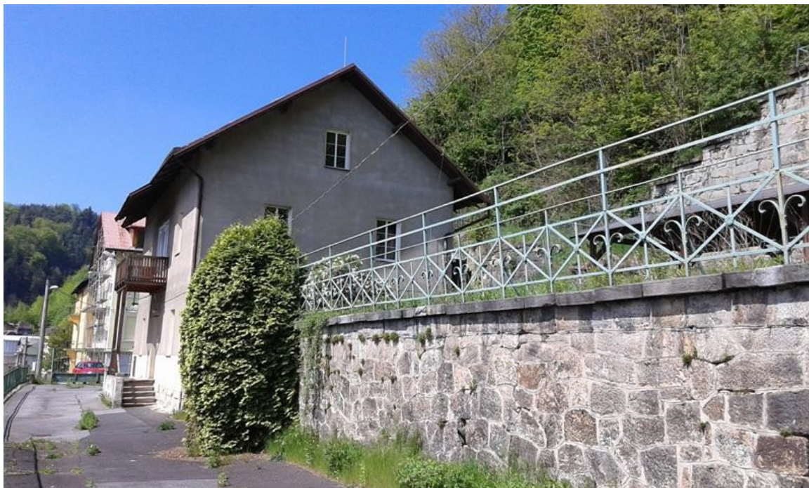
Pohled na objekt č.p. 7 – dílna, herna, prádelna,.. (ze směru od Hřenska)
