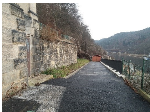
Vnitřní komunikace pod objektem vily
