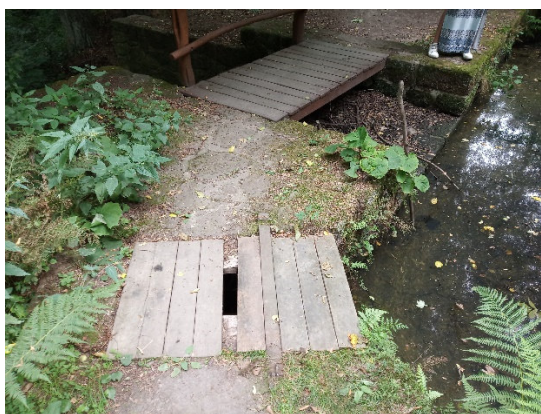
Pohled na poklop požeráku a bezpečnostní přeliv
