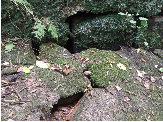
Detail dlažby v odpadním korytě pod bezpečnostním přelivem a odpadním potrubím
