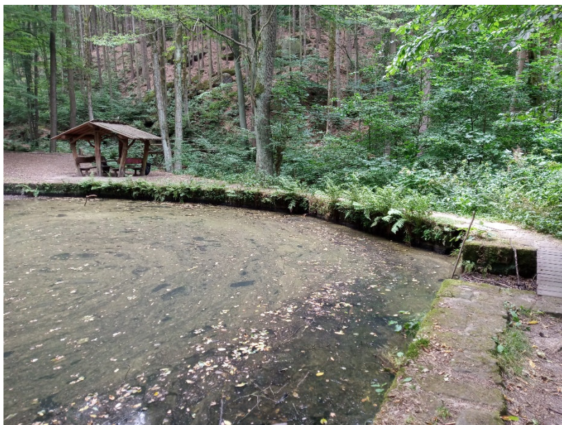
Stávající opěrní zdi na levém břehu a pohled na bezp. Přeliv a požerák
