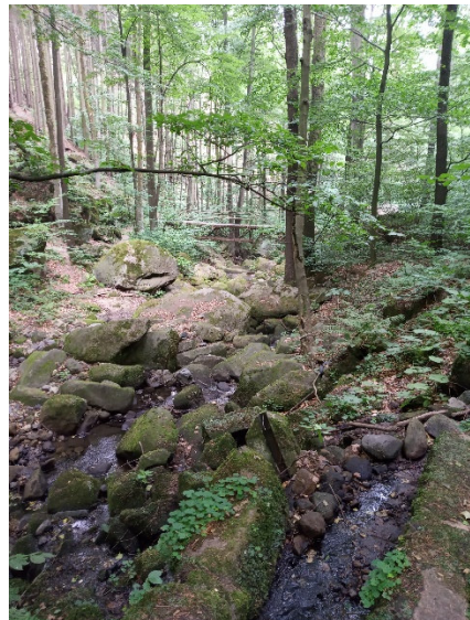
Pozůstatky opevnění na LB – viditelný pozůstatek (U profily) z přepouštěcího objektu
