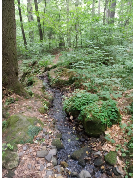
Pohled po toku na začátek opevnění koryta – na levém břehu chybějící zeď
