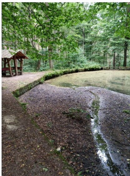
Stávající opěrní zdi na levém břehu
