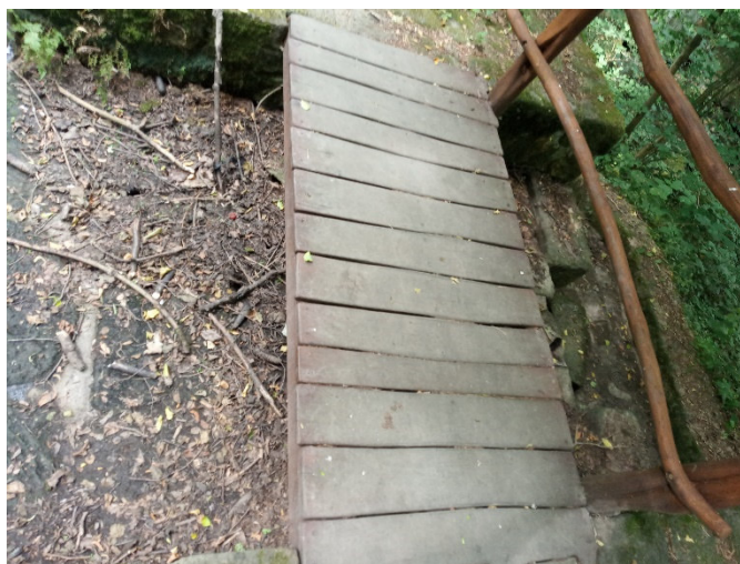
Pohled na bezpečnostní přeliv s lávkou
