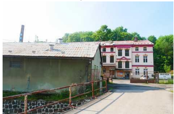
budova č. 3 a 1
