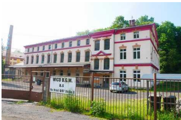
Budova 1 čelní pohled
